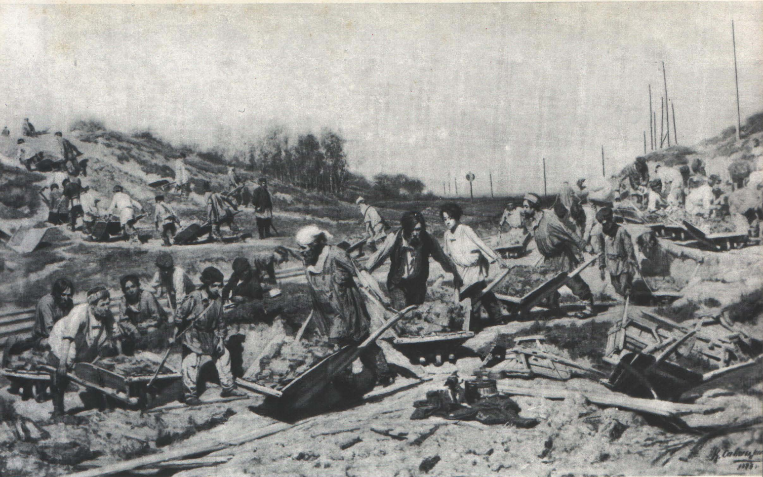
К. Савицкий. Ремонтные работы на железной дороге. Масло. 1874.
